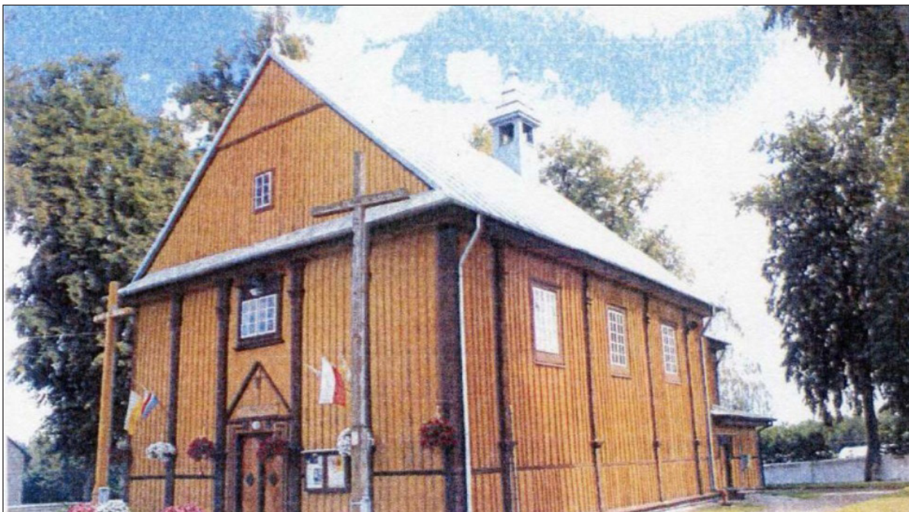
➤ Drewniany kościół wymaga pilnego remontu!
