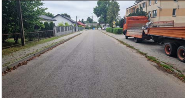
■ Przebudowa ul. Parkowej
