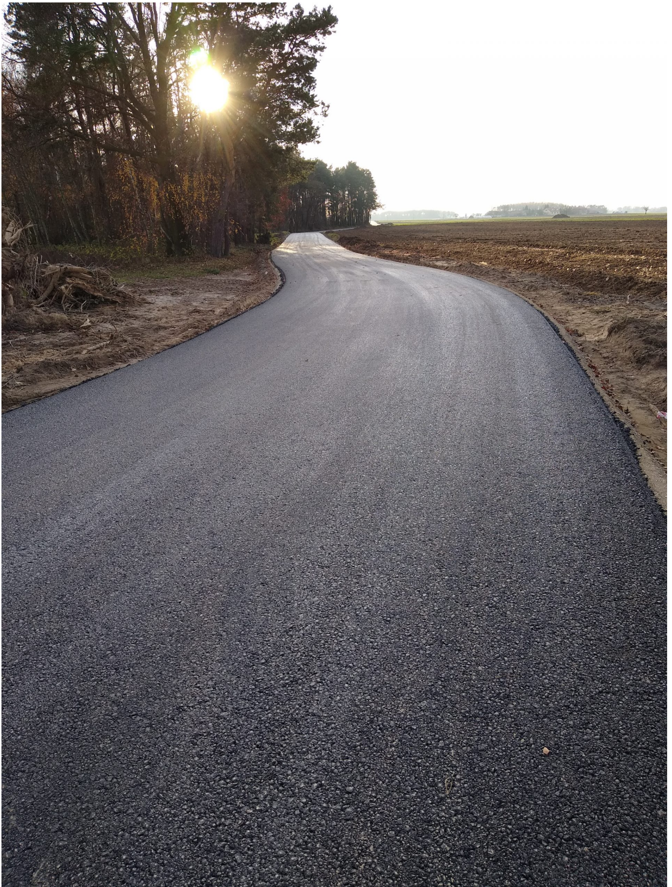
Trwają prace przebudowy drogi gminnej nr 102698 L między miejscowościami Bystrzyca, Otylin,
